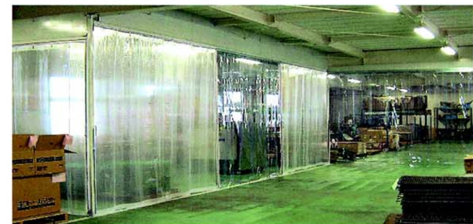
■ 工場内間仕切 D30レールにシート間仕切
