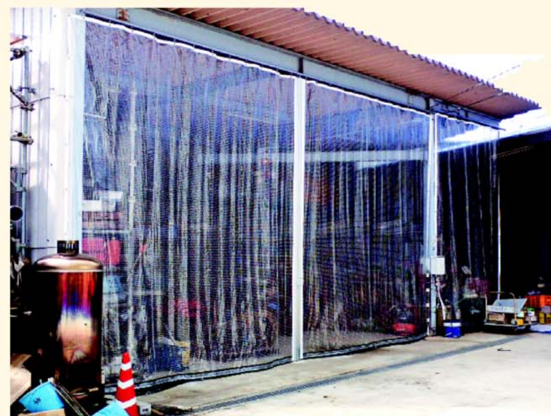
■ 倉庫開口部 D40レールにビニールシート
