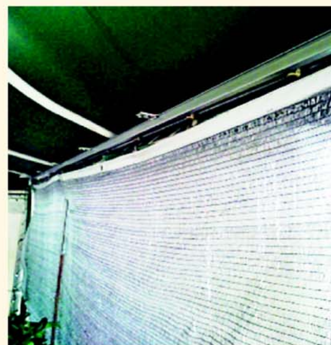
■ テント軒下 D40レールにビニールシート
