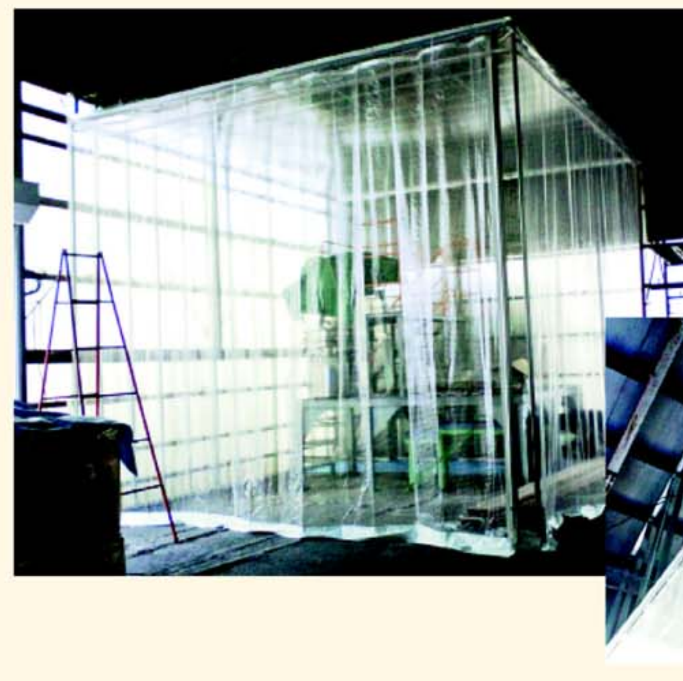
■ 倉庫作業場 D40レールにビニールシート
