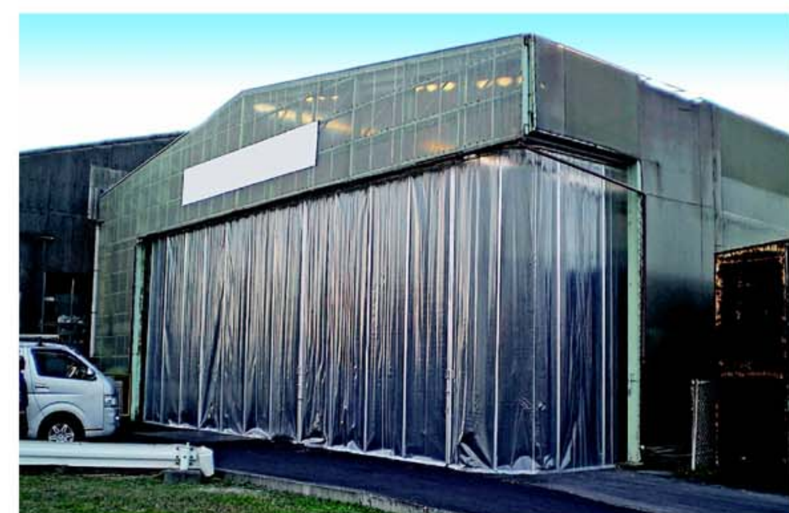
■ 工場開口部 D40レールにシート間仕切
