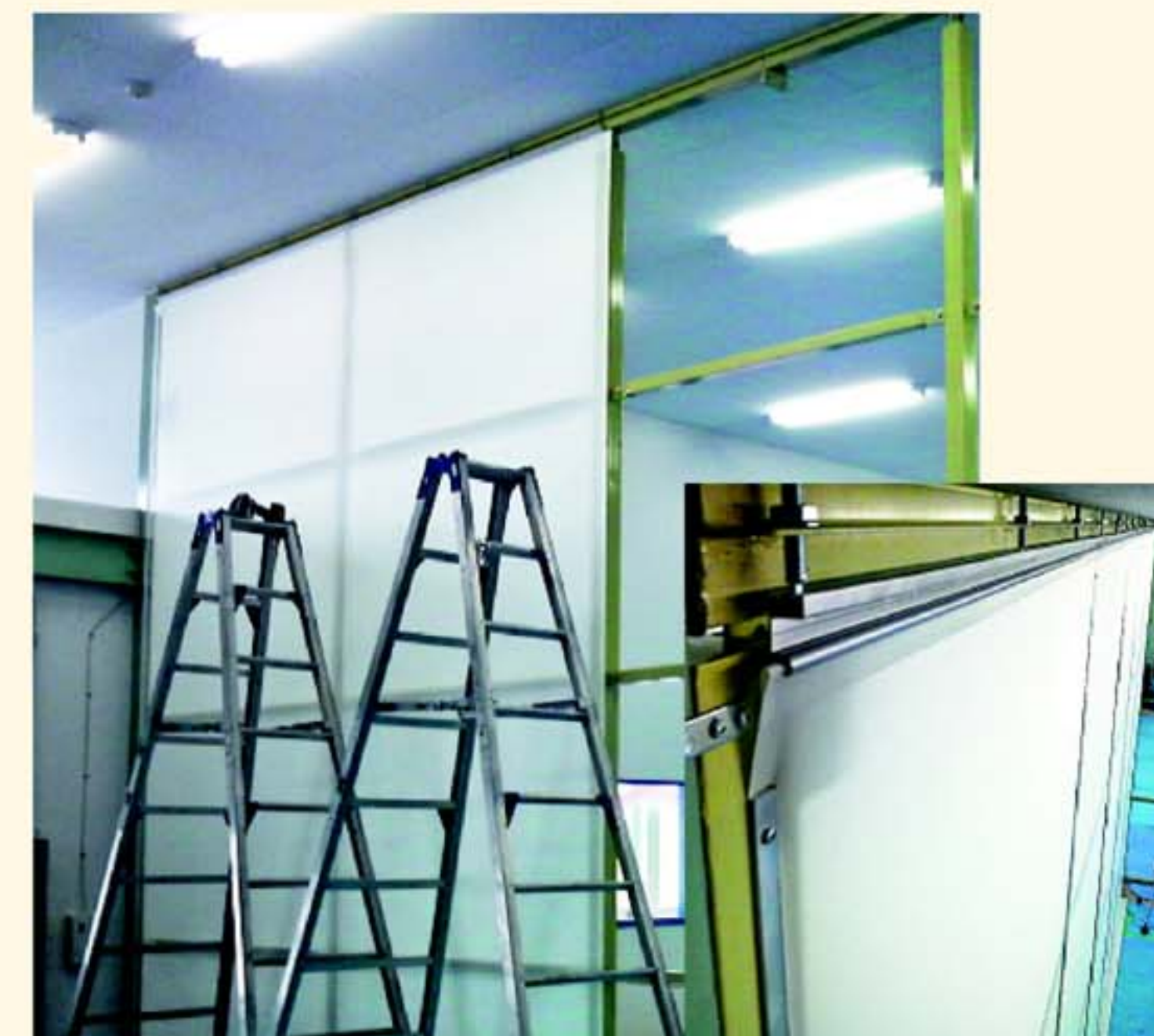
■ 壁面間仕切 テンションバーに間仕切シート
