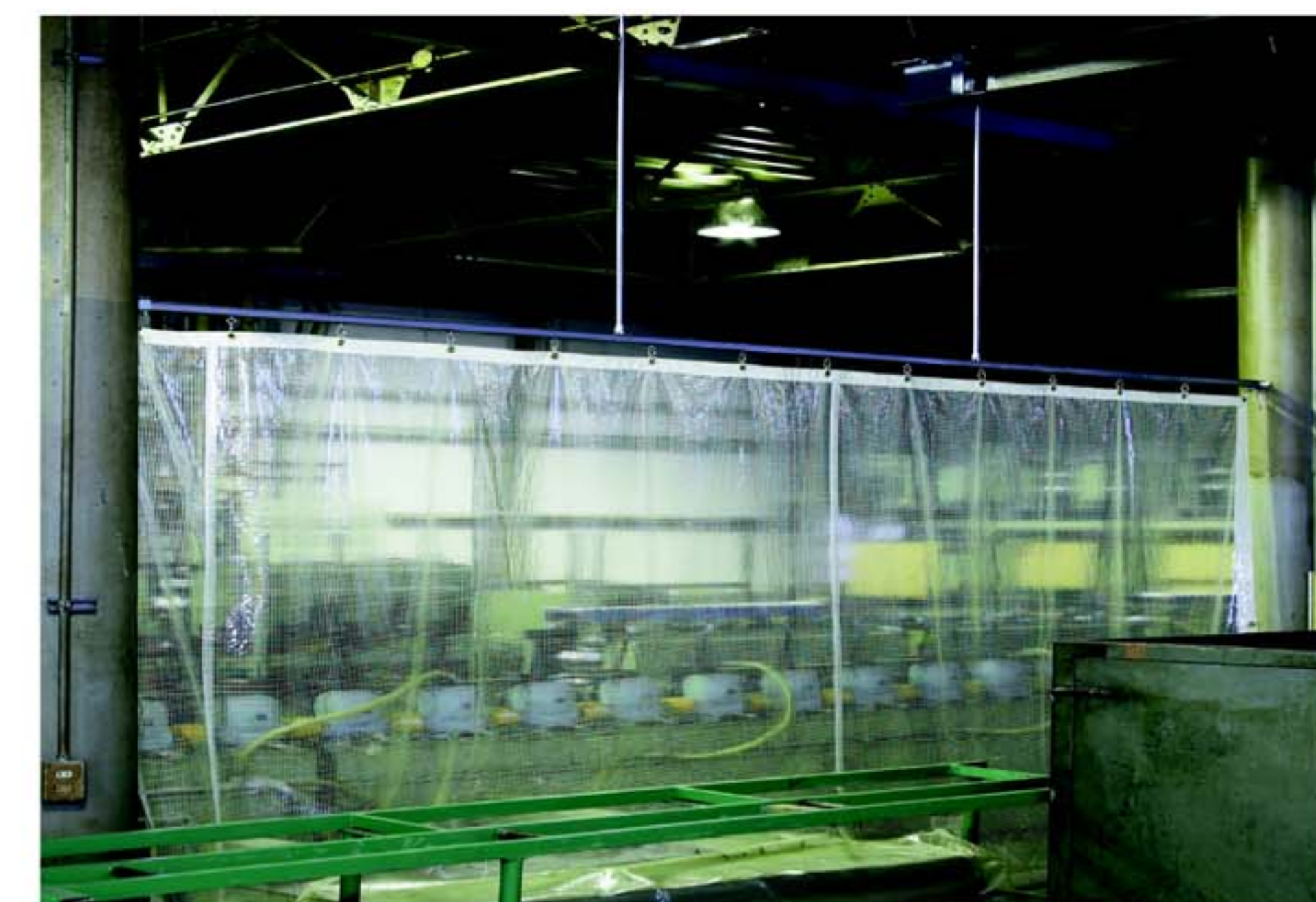
■ 工場内間仕切 吊棒とD40レールにビニールシート
